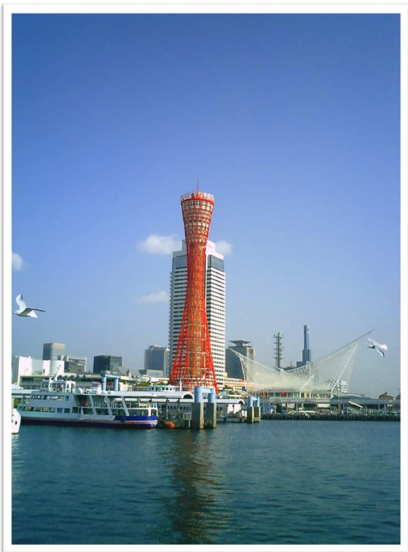
Гиперboloидная башня порта Кобе выдержала землетрясение в 7 баллов по шкале Рихтера. Япония. 2005
