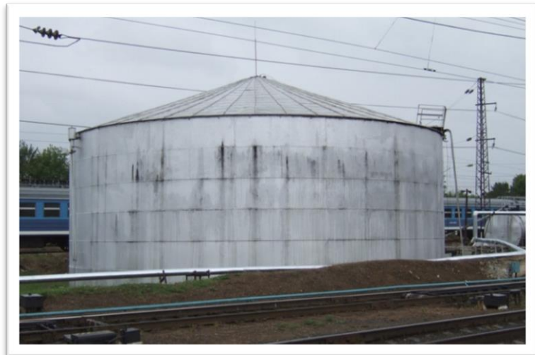
Старинный клепанный нефтяной резервуар Шухова на железнодорожной станции города Владимира. 2007
