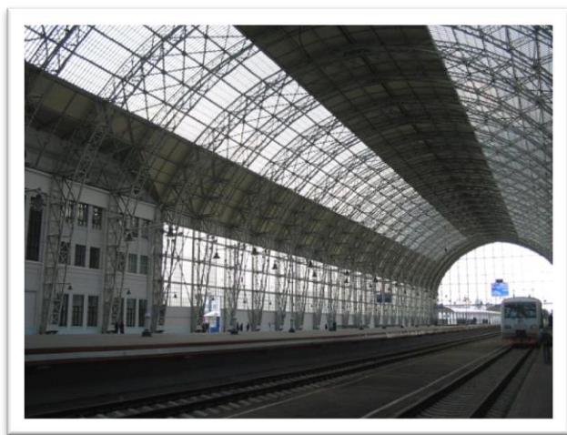
Металло-стеклянный дебаркадер Киевского вокзала в Москве
