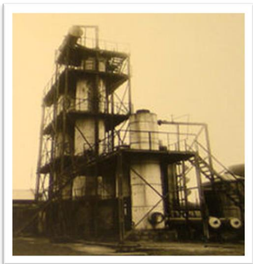
Установка В. Г. Шухова для термического крекинга нефти. 1931
