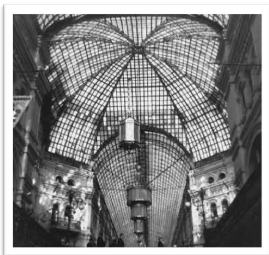
Металлостеклянные своды и купол перекрытия Верхних торговых рядов на Красной площади в Москве. Фотография С. В. Шухова 1960-х годов
